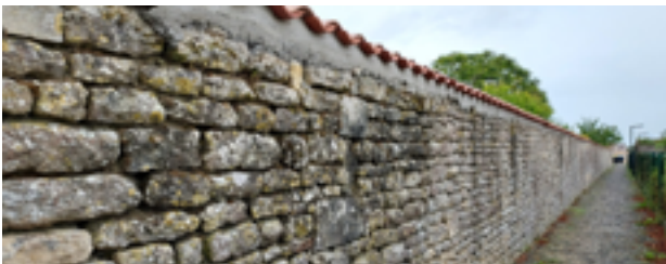
Réparation du mur des écoliers
